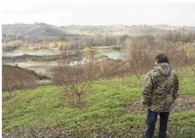
La zona dove deve essere realizzato il bacino di laminazione lungo il Senio
