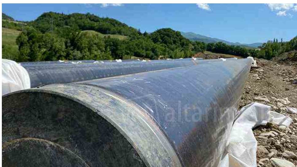
Lavori metanodotto in Valmarecchia.
