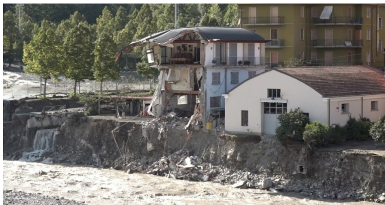
Figura 1: settembre 2015, effetti dell'erosione spondale in seguito ad un eccezionale evento di piena in Val Nure (PC) - (da: F. Bonafede, 2020)
